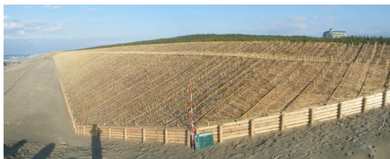
湯野浜海岸における砂丘造成工事の完成
