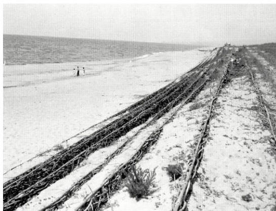
防浪垣設置による砂丘の築造
